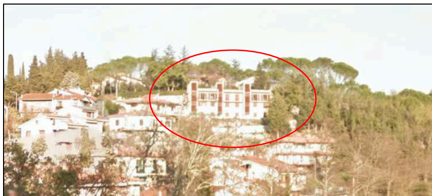
Ambito M1 - Vista dell'intervento da valle
